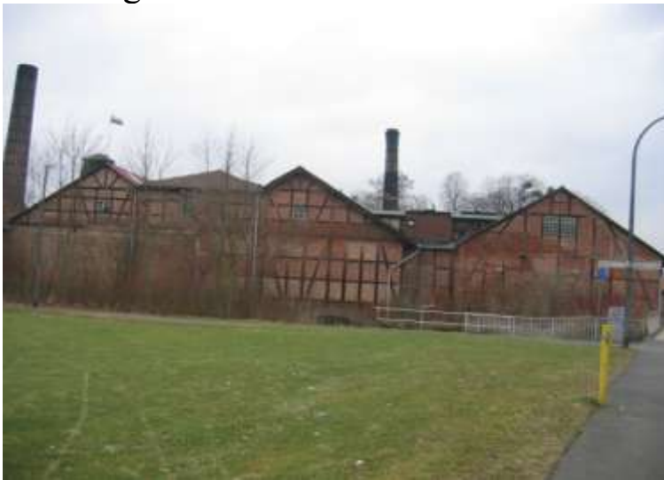
Ansicht der Salinen-Gebäude
